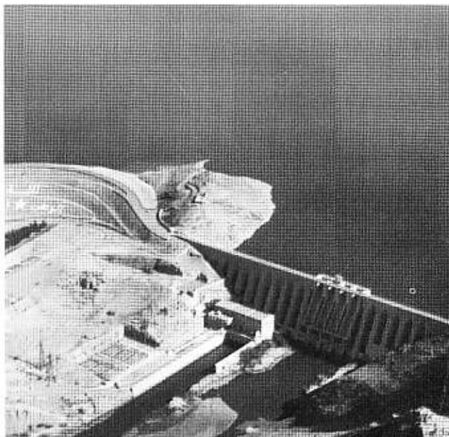
Barrage Al Massira
